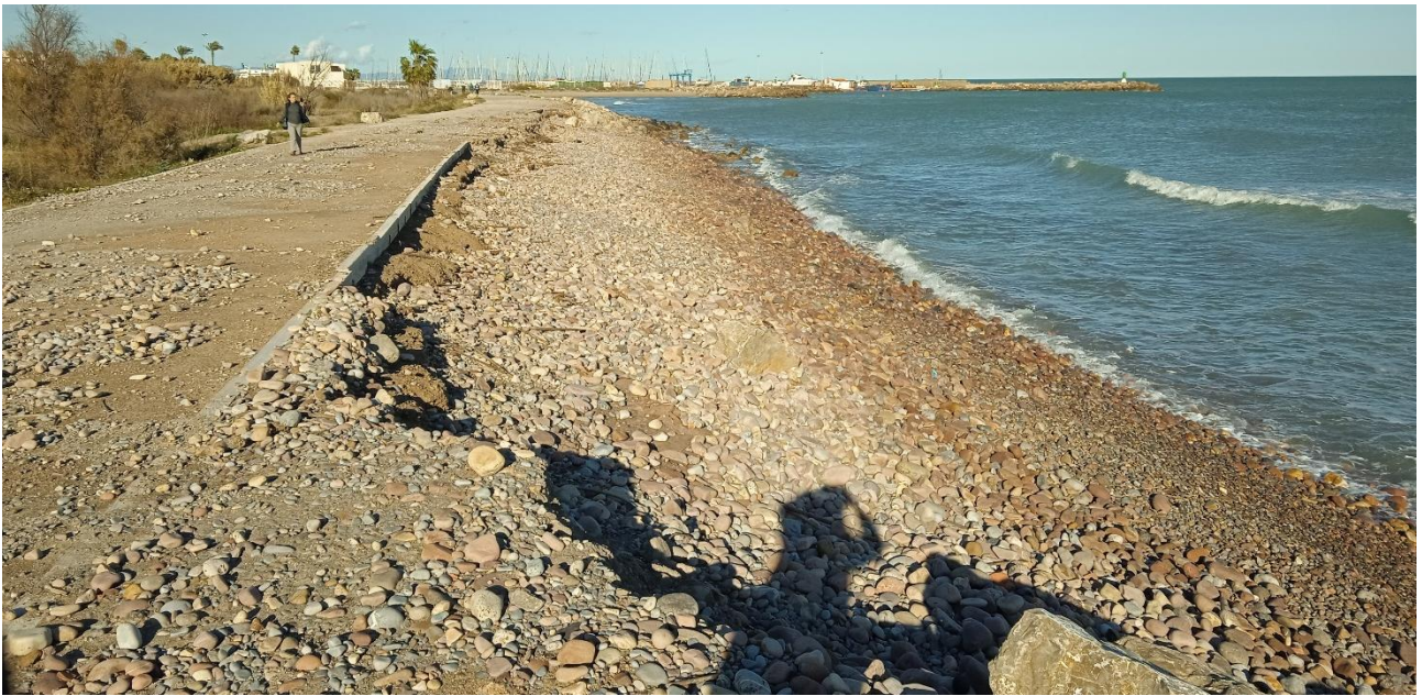
Tramo 2 con subtramo 2.b. Vista del subtramo más largo con erosión y traviesas de madera a la vista.
