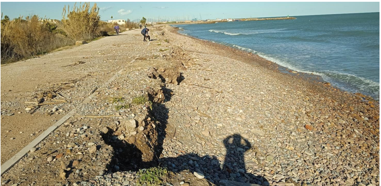
Tramo 2. Erosión reciente en el talud sin escollera, sin destapar aún el borde exterior de las traviesas de madera.
